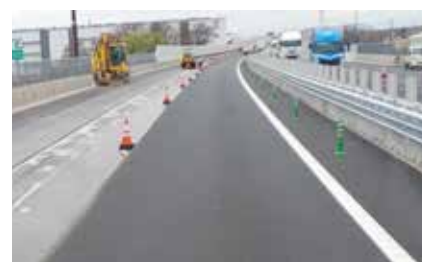
4車線化工事完了前の圏央道
