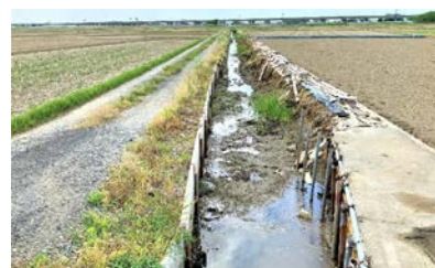
三ヶ日塚から、隼人堀川に伸びる排水路
