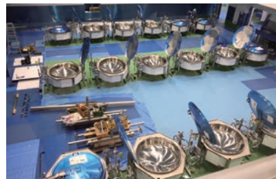
建設中の給食センター
