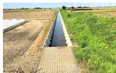
整備された丸谷神ノ木地区の雨水排水路
