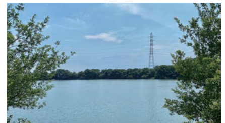
水上太陽光発電事業予定地 (清久大池)
