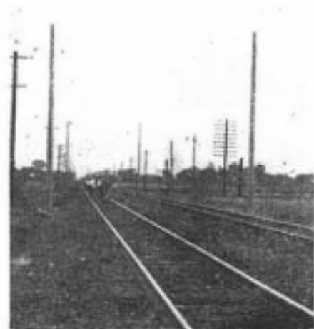
電化工事のすすむ 久喜駅付近（昭和31年）
