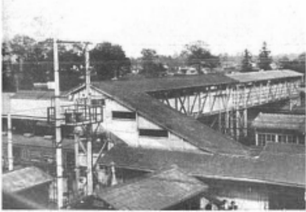
改装前の久喜駅（昭和43年）
