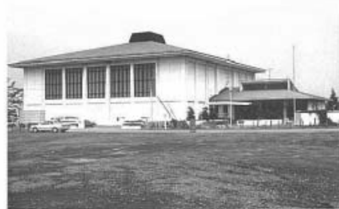
久喜勤労者体育センター 昭和59年に完成
