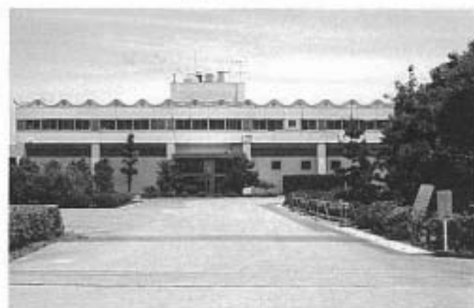
下水道古利根川処理センター 昭和49年に完成
