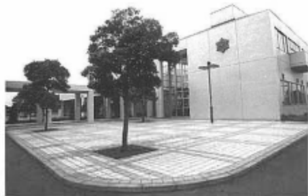
消防本部の新庁舎(平成元年完成)
