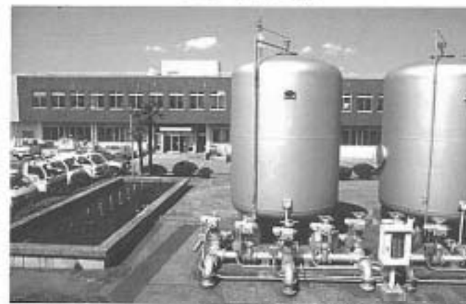
吉羽浄水場 昭和47年に完成
