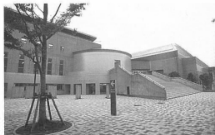
久喜市総合体育館 平成5年に完成
