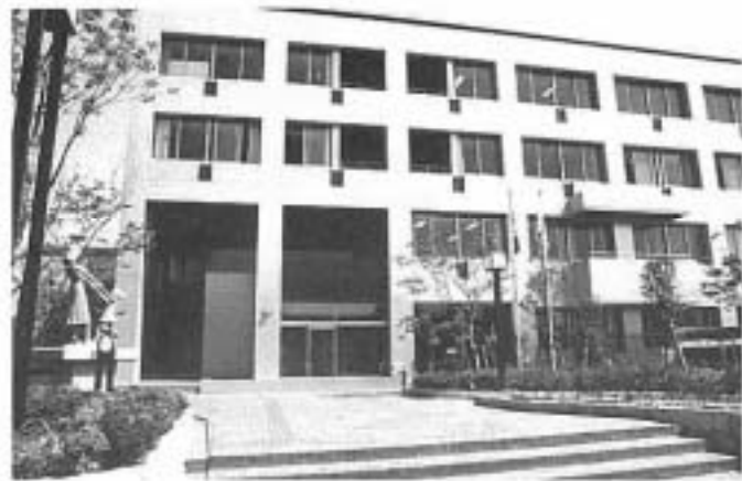
中央公民館 平成3年に完成
