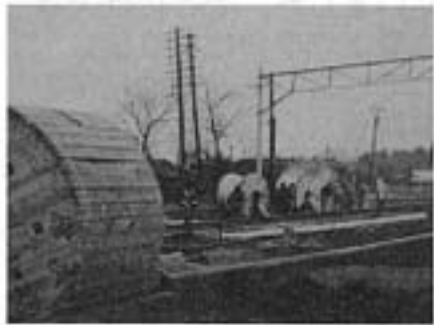
32 東北本線電化工事(久喜駅付近) 昭和32年4月
