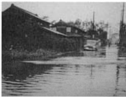
19 冠水した幸手新道
