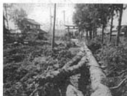
28 千勝神社脇の道路建設
