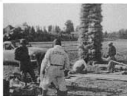
41 水道管敷設工事2
