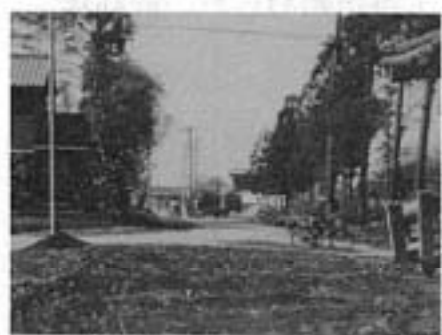
29 道路となった千勝神社参道
