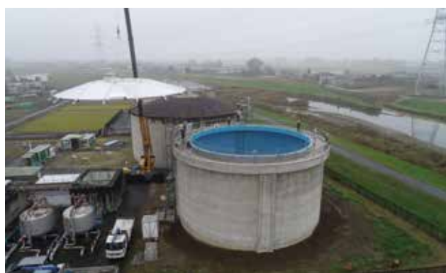
八甫浄水場 1号配水池の更新工事
